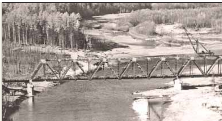
📍 Монтаж моста через Амгунь
