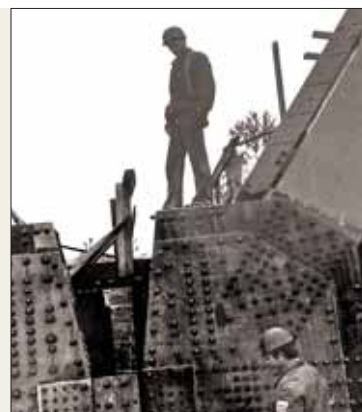
📍 Бригада на монтаже моста
